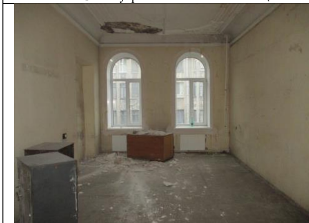
Фото № 15 – Внутреннее состояние помещения
