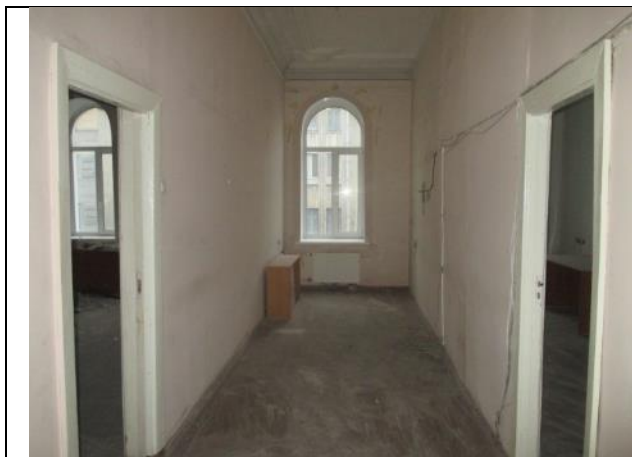
Фото № 13 – Внутреннее состояние помещения
