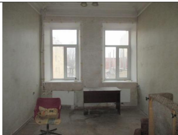
Фото № 6 – Внутреннее состояние помещения
