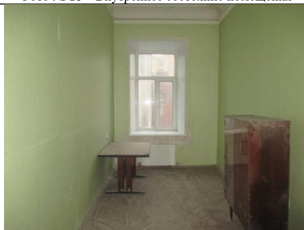
Фото № 12 – Внутреннее состояние помещения
