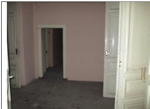
Фото № 5 – Внутреннее состояние помещения
