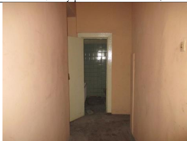
Фото № 8 – Внутреннее состояние помещения
