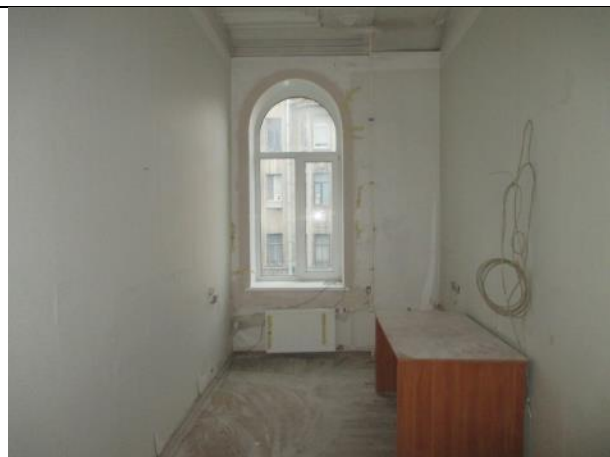
Фото № 14 – Внутреннее состояние помещения
