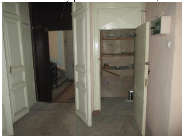
Фото № 16 – Внутреннее состояние помещения
